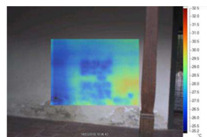
Figura 4. Posible mampuesto de adobe.
